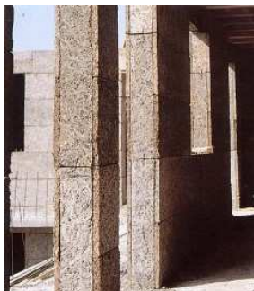
Obrázek 5,1: Dvojitá zeď s dutinou má vysokou tepelnou setrvačnost
